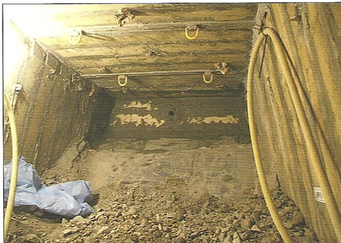
Obr. 13 První ruční ražba s výdřevou v kalotě propojky; na konci lze vidět odkryté stávající tunelové litinové ostění
