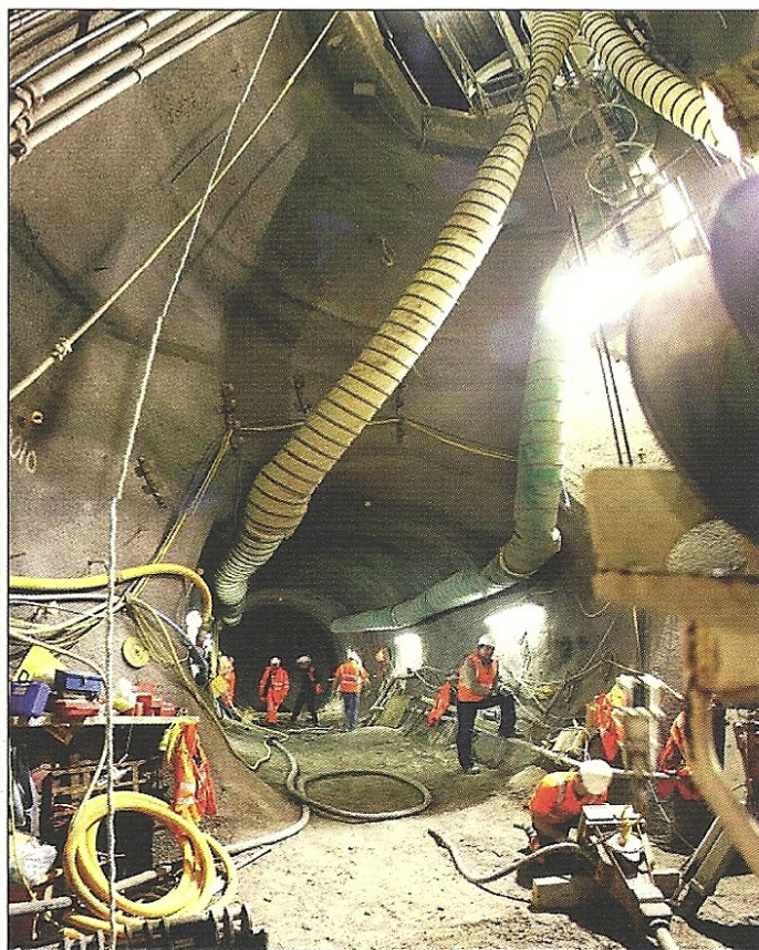
Obr. 5 Budování tunelu Hockeystick ze šachty Maiden Lane Fig. 5 Construction of the Hockeystick tunnel from Maiden Lane shaft
