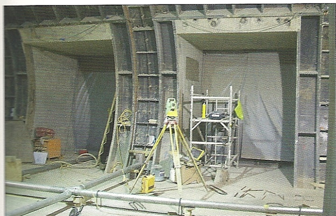
Obr. 14 Dvojice dokončených propojek v přístupu na trasu Northern Line Fig. 14 A pair of finished crosspassages in the Northern Line Access
