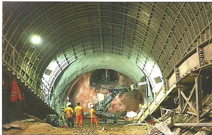
Obr. 9 Bagr s nástavbou manipulátoru používaný k budování prstenců z litinových dílců v eskalátorovém tunelu NLA
